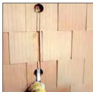
Dégager les rainures pré-taillées avec un marteau et un burin.
