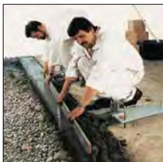
Étalez de manière assez compacte le mortier d'assise (sable 0/5 et ciment) et placez les briques de terre cuite ThermoPlan® en contrôlant régulièrement leur niveau et leur alignement.
