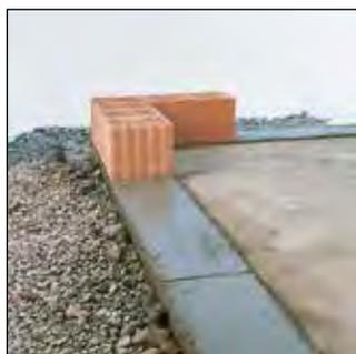
Le procédé ThermoPlan® exige la mise en œuvre d'un mortier d'assise parfaitement horizontal.
