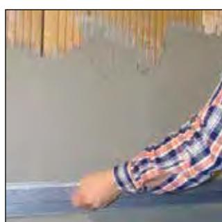
Le régulateur de fond évite les spectres de joints et facilite l'application du plâtre sur les murs en briques de terre cuite.
