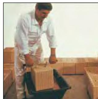
Les briques sont ensuite trempées légèrement dans le bac à mortier colle, sans racler. L'usage d'un rouleau de mortier-colle est également possible.
