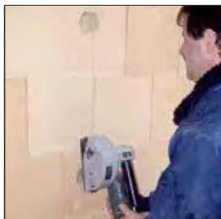
Réaliser les saignées dans les murs à l'aide d'une rainureuse
