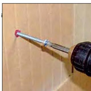
Observer les indications du fabricant de chevilles quant à l'épaisseur et la longueur de la vis, afin de garantir une fixation optimale!
