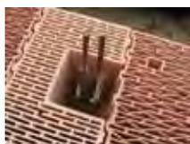
Recommandation: poser les briques d'arase dans le mortier du 1er rang.
