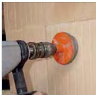
Tracer la boîte de dérivation et carotter à sec à l'aide d'une scie à cloche diamantée et d'une perceuse d'utilisation courante sans percussion.
