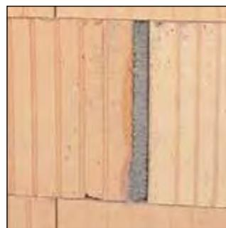
Les joints verticaux d'une largeur de maximum de 5 mm sont laissés ouverts. Les joints plus larges seront également fermés à l'aide de mortier isolant LM21.
