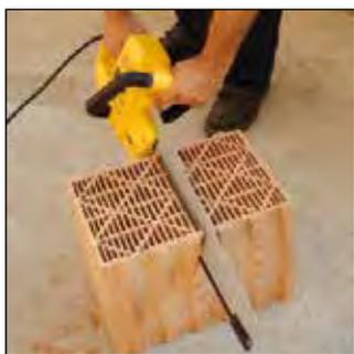
Le sciage du système JUWÖ ThermoPlan® s'effectue de préférence à l'aide d'une scie Alligator (comme par exemple le type Dewalt 394).
