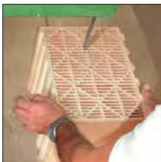
Les briques JUWÖ peuvent également être coupées avec une scie diamantée à eau ou même avec une scie à ruban (type de lame à vérifier avec le fabricant).
