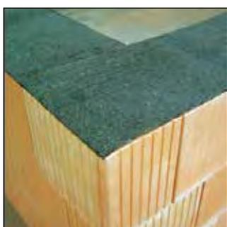
La protection des maçonneries contre la pluie et la neige est recommandée en fin de journée. Spécialement pendant l'hiver ou il faut éviter que la brique ne soit détrempée.
