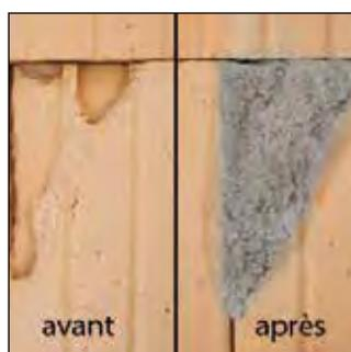
Les épaufrures seront rebouchées au moyen d'un mortier isolant LM 21.
