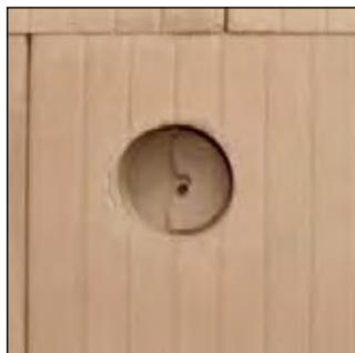
Nettoyer la cavité ainsi obtenue et vous obtenez un logement idéal pour recevoir un boîtier électrique!
