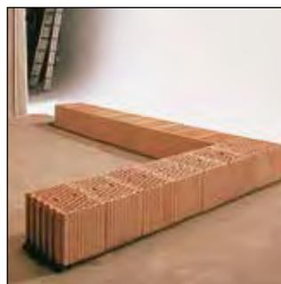
Après avoir réglé le 1er rang sur le mortier d'assise le collage des briques ThermoPlan® peut commencer.
