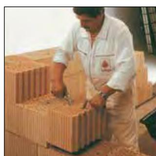
Les briques ThermoPlan® sont ajustées. Les joints verticaux s'assemblent parfaitement grâce à leurs emboitements.
