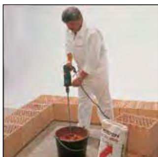
Préparation du mortier-colle en poudre au moyen d'un malaxeur. Entre 8 et 9 litres d'eau par sac de 25 kg.
